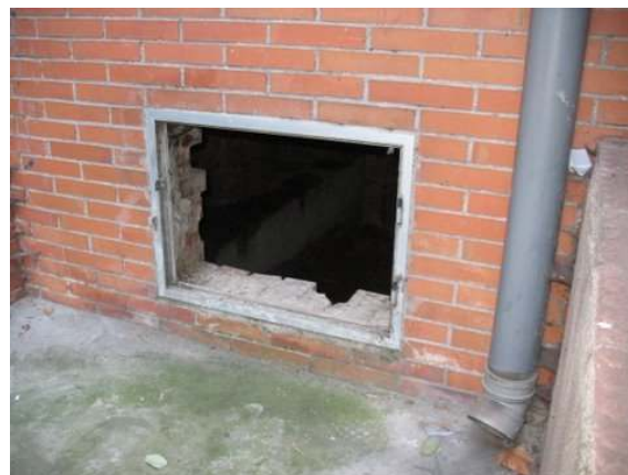
Trampilla: bajando escalera hacia cuarto de calderas
